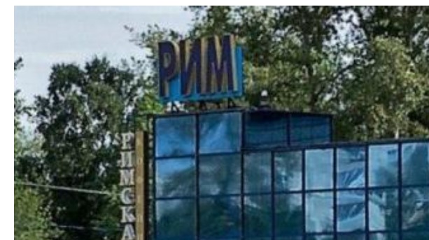
Плохо. Крышная установка с подложкой
